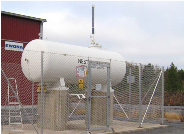
Kuva 2. Kiinteälle perustukselle asennettu maanpäällinen säiliö.
